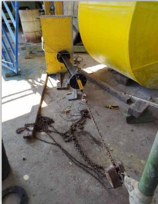
Figura 30. Prueba de activación de Sistema Mecánico. Fuente. Gecoproes SAS.
