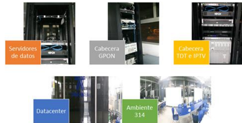
Figura 3. Elementos considerados en el plan de mejoramiento de ambientes de telecomunicaciones del CEET Fuente: SENA - CEET
